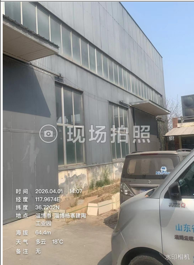
厂房外部照片
