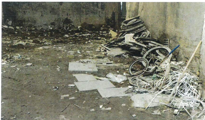
泮水镇南泮村佛斯特建陶厂车间内垃圾回收站整改前照片
